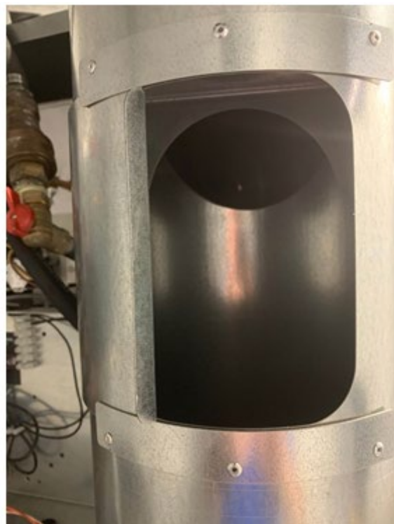
APERTURA A SCORRIMENTO PER LA PULIZIA ORDINARIA
