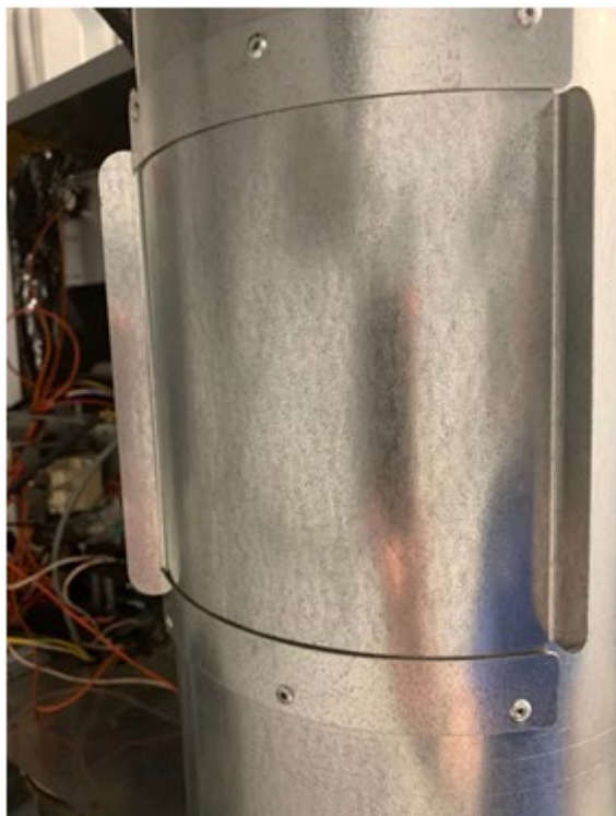
Εικόνα 7-5 Προστατευτικό πάνελ αγωγού εξάτμισης κατά τη λειτουργία
